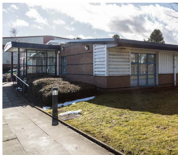
Instalação da Apex em Loanhead
